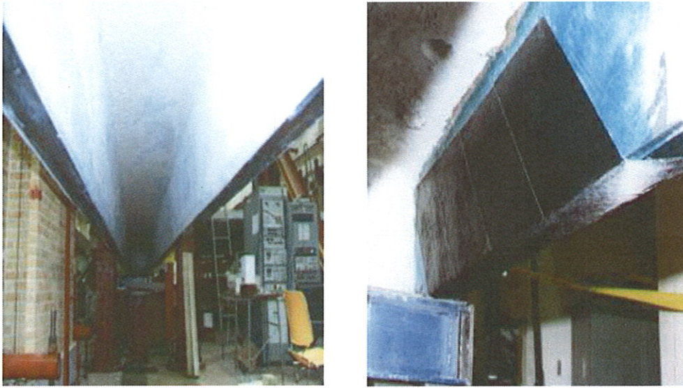
حالة الكمرات بعد تدعيمها بألواح ورقائق المواد البوليمرية المسلحة بألياف الكربون
