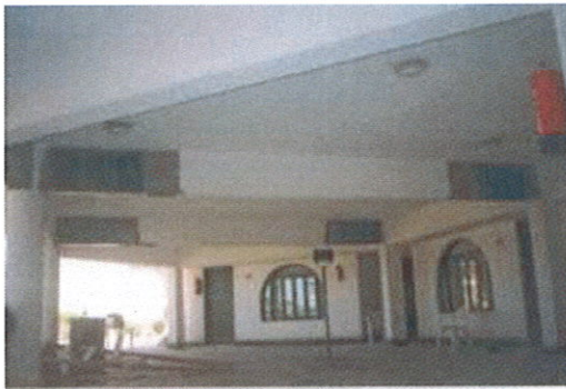
تدعيم الكمرات برقائق المواد البوليمرية المسلحة بألياف الكربون لزيادة مقاومتها للقص
