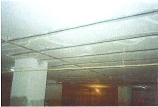
تدعيم السقف في منطقة عزوم الإنحناء الموجبة
