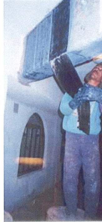
تدعيم الكمرات برقائق المواد البوليمرية المسلحة بألياف الكربون
