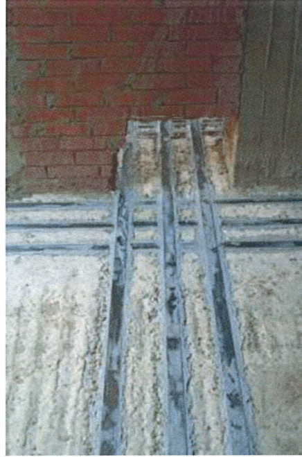
تدعيم السقف بدون الحاجة إلى تكسير الحوائط
