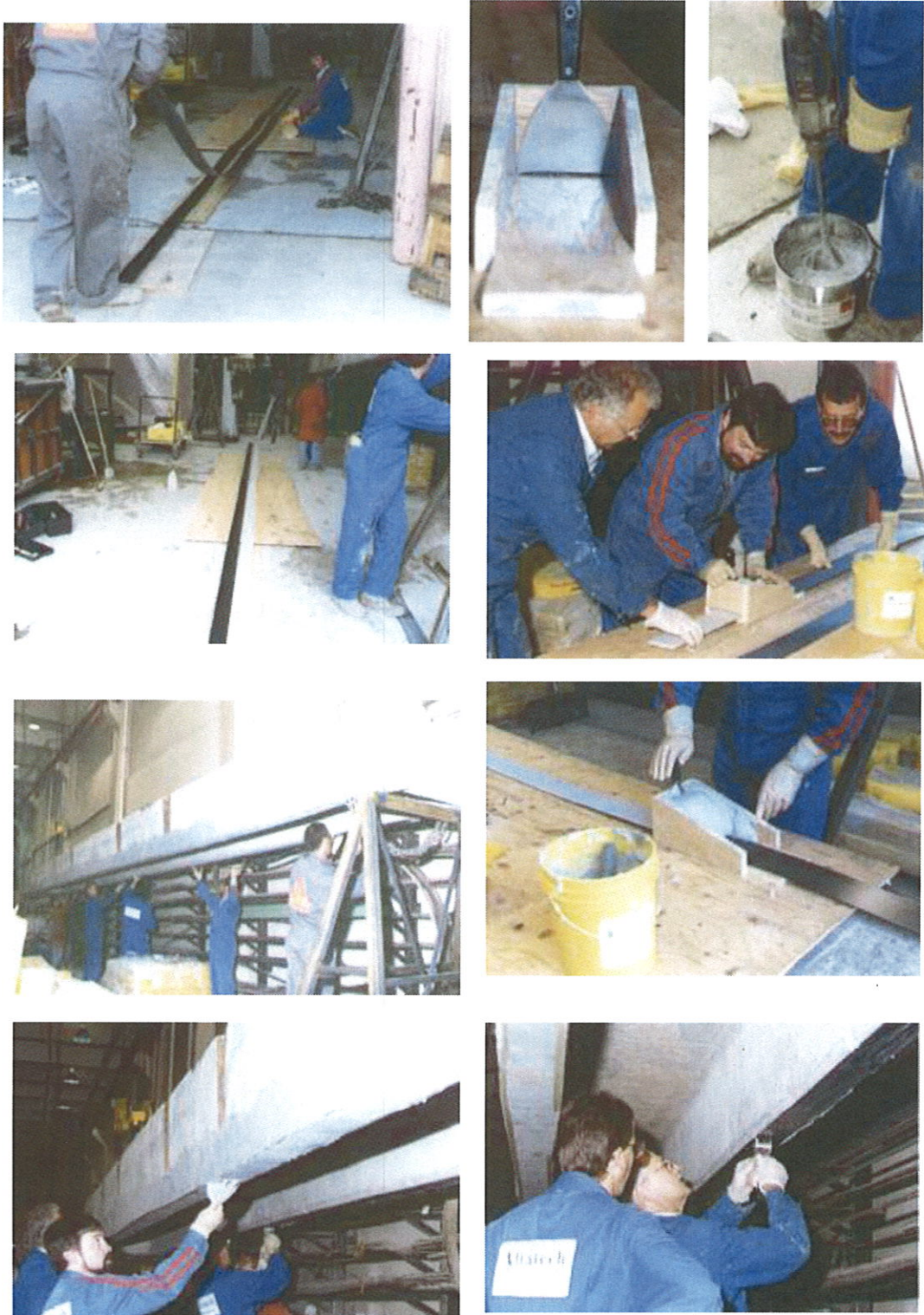
شكل رقم ٦. خطوات تثبيت ألواح المواد البوليمرية المسلحة بألياف الكربون على الخرسانة
