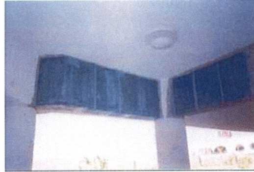
تدعيم الكمرات برقائق المواد البوليمرية المسلحة بألياف الكربون لزيادة مقاومتها لعزوم الالتواء
