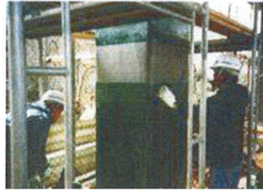
شكل رقم ٥. إعادة تأهيل أعمدة خرسانية لكوبري وجراج متعدد الطوابق برفائق بالمواد البوليمرية المسلحة بالألياف الكربون
