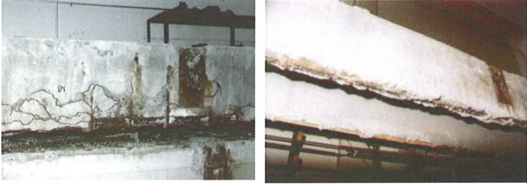
الحالة الراهنة للكمرات: صدأ حديد التسليح - أنهيار الغطاء الخرساني لحديد التسليح - شروخ متنوعة
